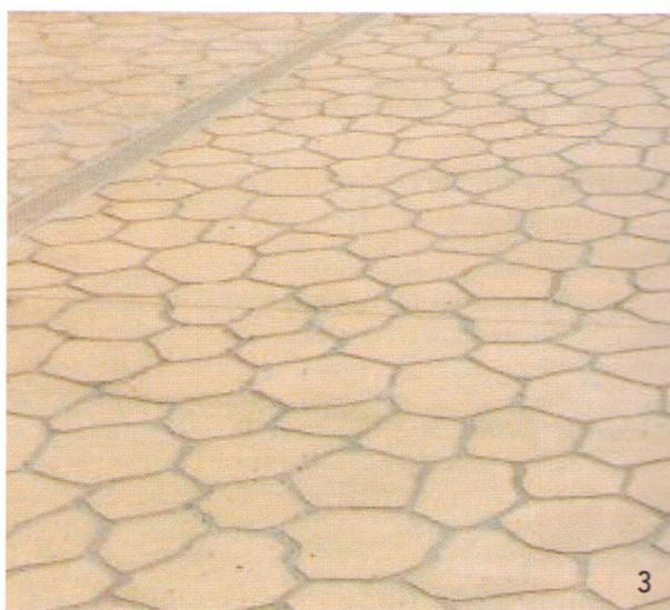
3- "Lumiliss® Empreinte", un béton de décoration VM Béton avec impressions multiples (dalles, pavés) à traiter pour éviter de dérapier.
